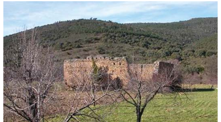
Ruinas del castillo de Malamoneda, a 100 m de la torre.
